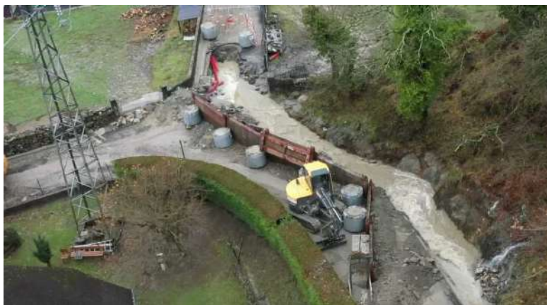
Les batardeaux posés pour dériver les eaux (route de la Caoubère)
