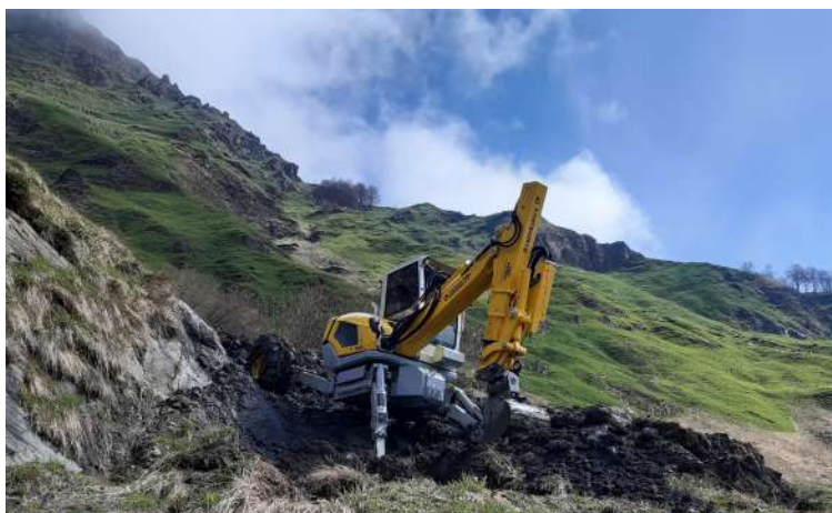
Travaux de guidage des eaux à la pelle-araignée secteurs Clot dou Loup (Arriutort) et Semoun.
