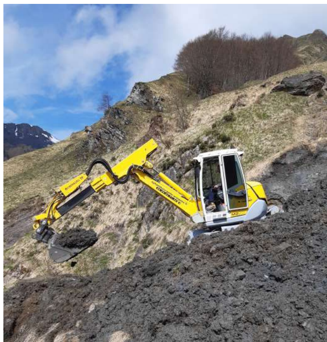
Travaux de guidage des eaux à la pelle-araignée secteurs Clot dou Loup (Arriutort) et Semoun.
