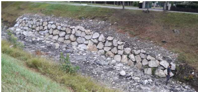
Création d'un mur de soutènement dans l'Arriusè (réalisés par la CCVO)
