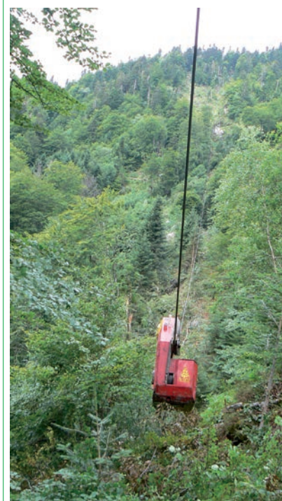
Câble à Espouey
