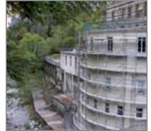
Façade Ouest, réfection
