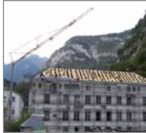
Réfection de la toiture
