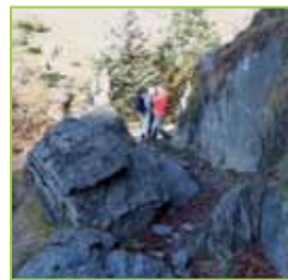
Aule : avant sécurisation
