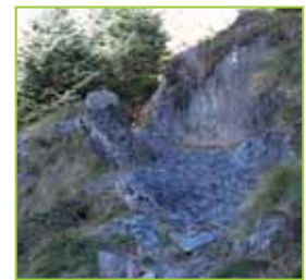
Aule : après sécurisation
