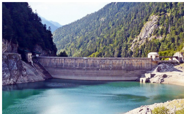
Le barrage hydroélectrique de Fabrèges
